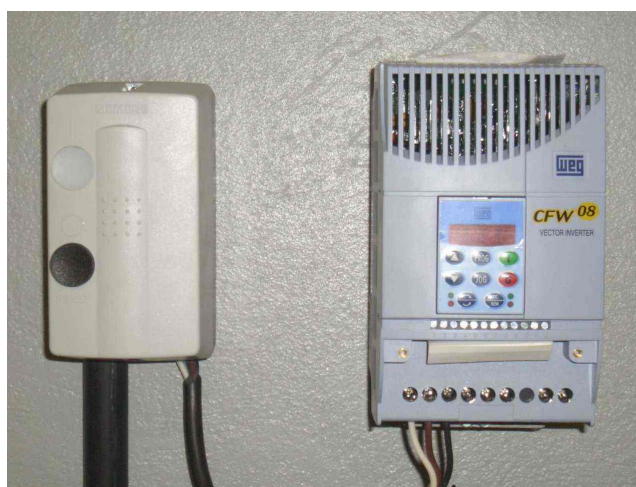
Figura 12 - Inversor de frequência e botoeira de proteção
